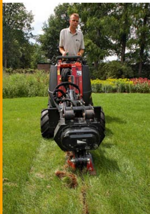
Met de kabelploeg leidingen ingraven betekent weinig herstelwerkzaamheden.
