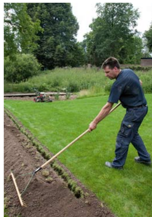
Herstelwerkzaamheden na gebruik van de sleuvenfrees.
