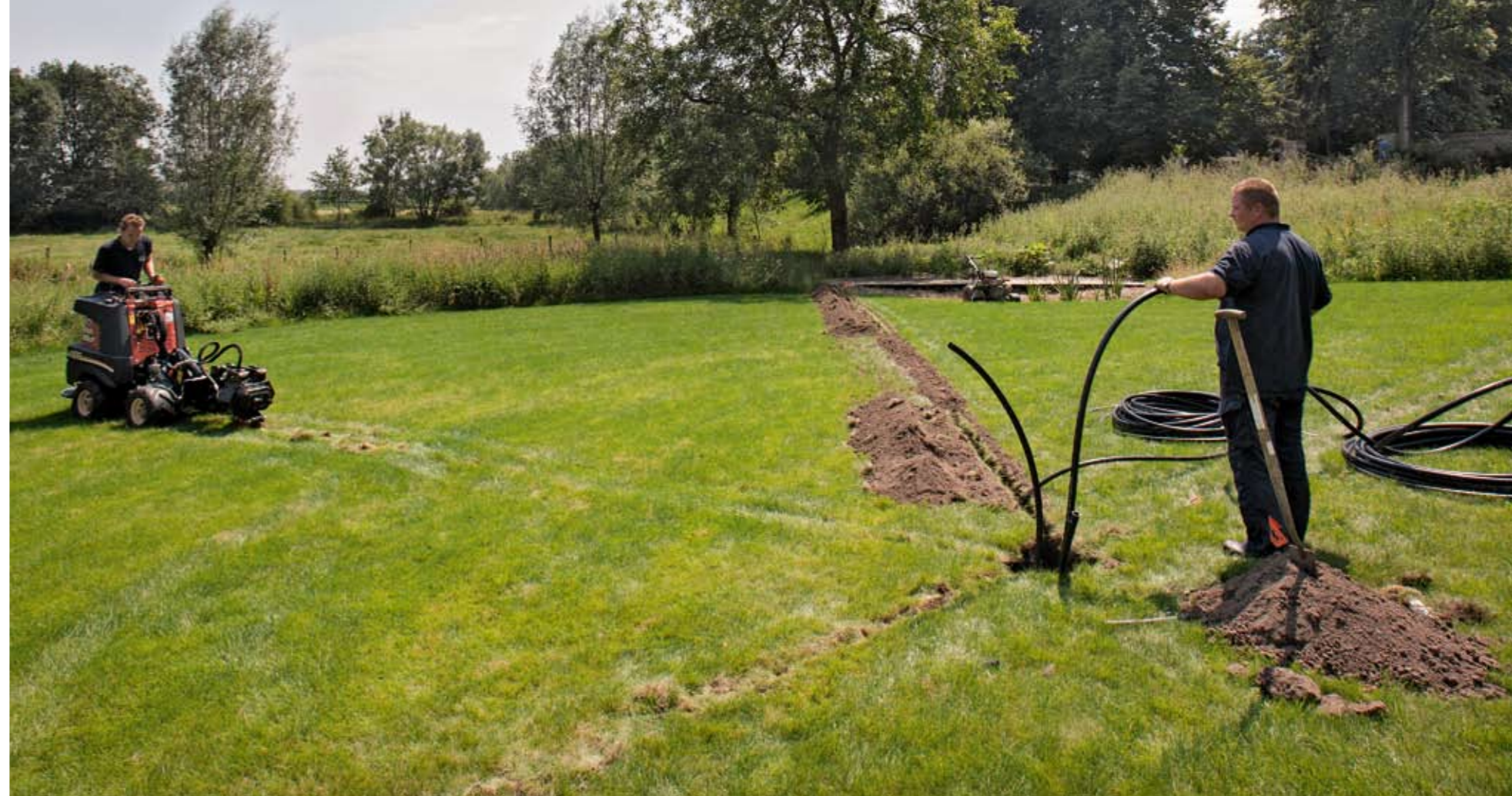
Medewerkers van Bos Watertechniek leggen een beregeningsinstallatie aan in een particuliere tuin in Amerongen.
